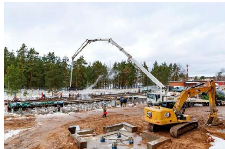
Начало заливки ростверка 21.12.2023
