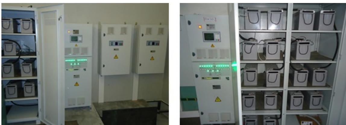
Рис. 52. Оборудование для реконструкции системы оперативного тока.
