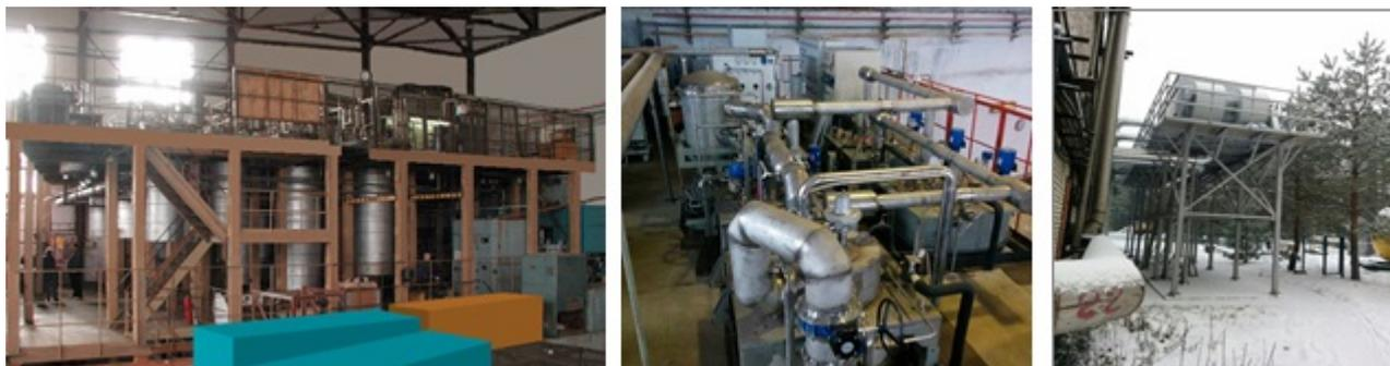
Рис. 48. Гелиевые рефрижераторы КГУ-1600/4,5 (слева), ожежитель гелия ОГ-1000 (в середине) водооборотная система охлаждения компрессорной станции (справа).
