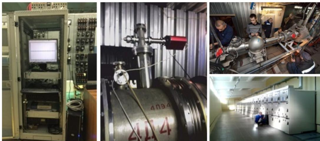
Рис. 2. Модернизированная система питания и защиты магнитов (а), один из элементов вакуумной системы (б), система диагностики (в) и электроснабжения (г) Нуклотрона.
