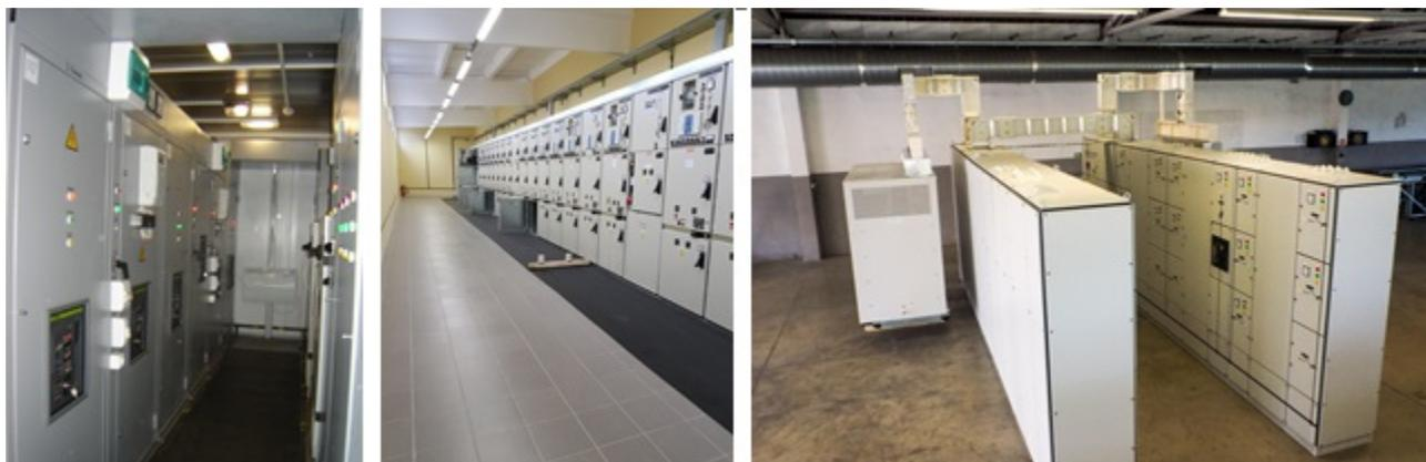
Рис. 50. Реконструированные электроподстанции №42 (слева) и №13 (посередине), а также оборудование, закупленное для подстанции №11 (справа).
