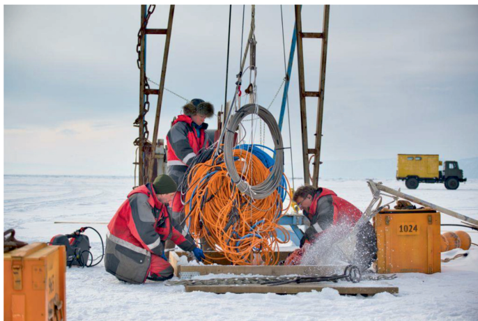
Работы по монтажу гирлянды
