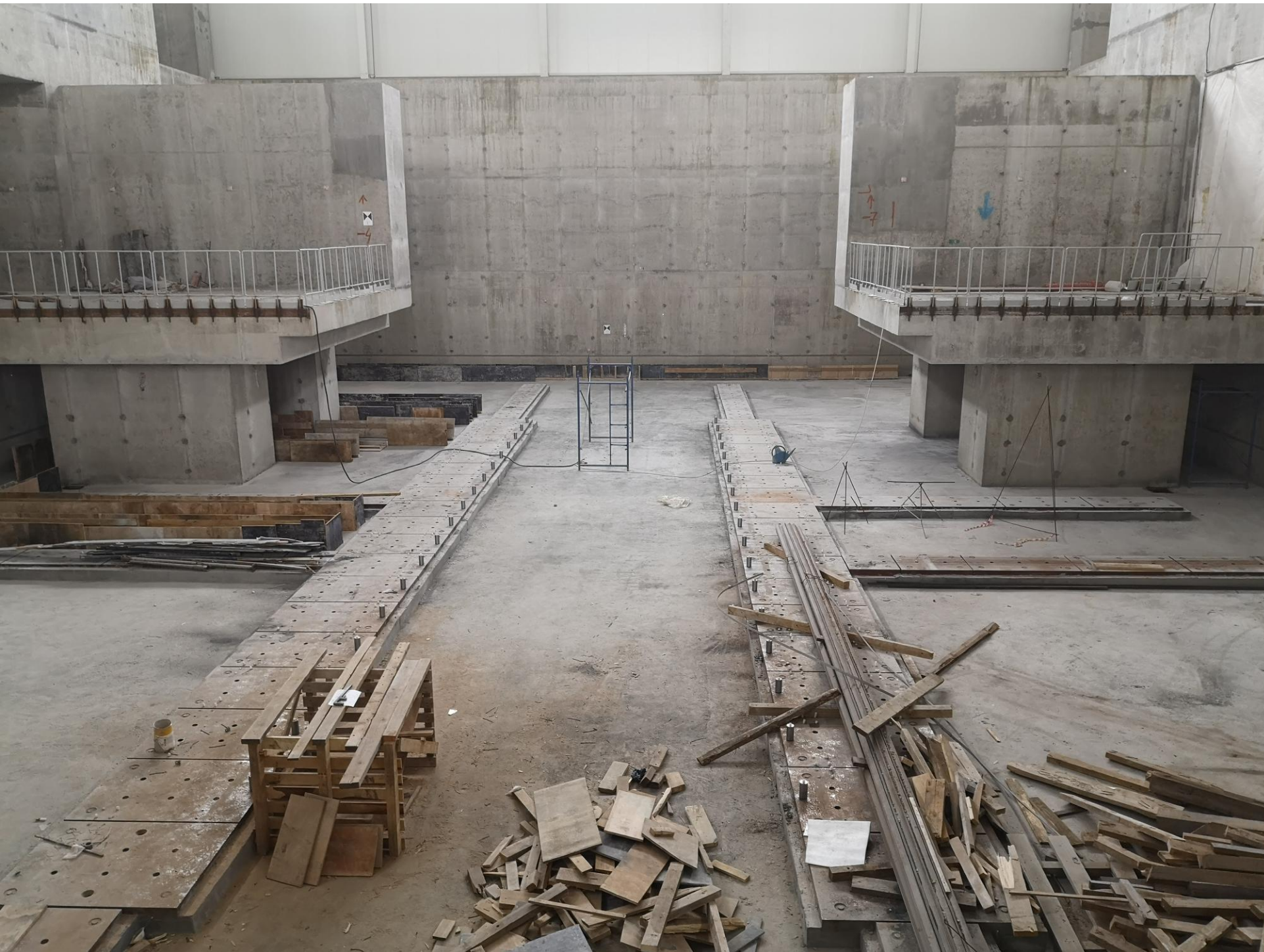
В фундаментные плиты смонтированы заземляющие электроды.
