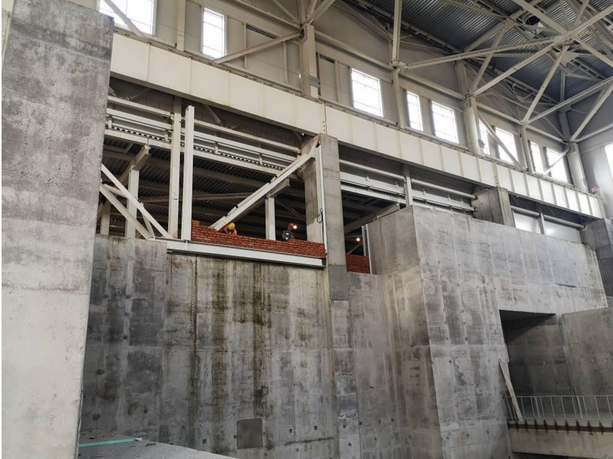
Закладка кирпичом восточной части стены зала SPD.
