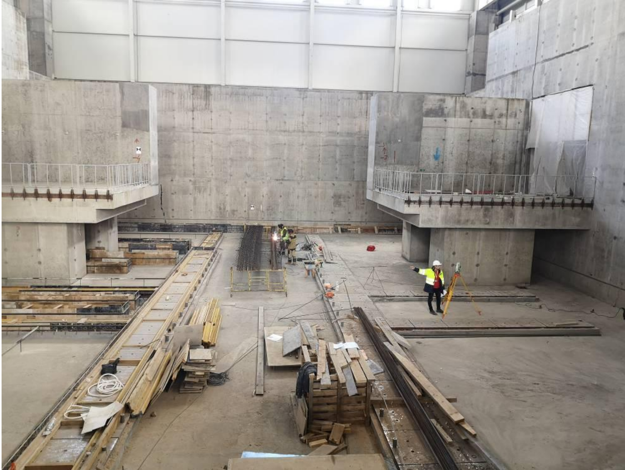
Сварка металлических уголков для технологических каналов, перед заливкой бетона.
