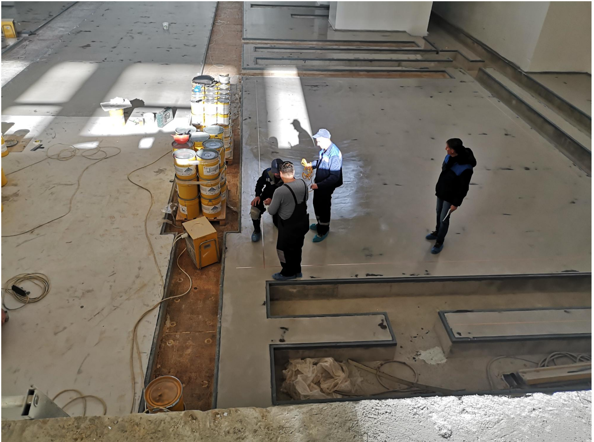
21.10.2021 нанесение токопроводящей ленты на черновую заливку пола прямка зала SPD.
