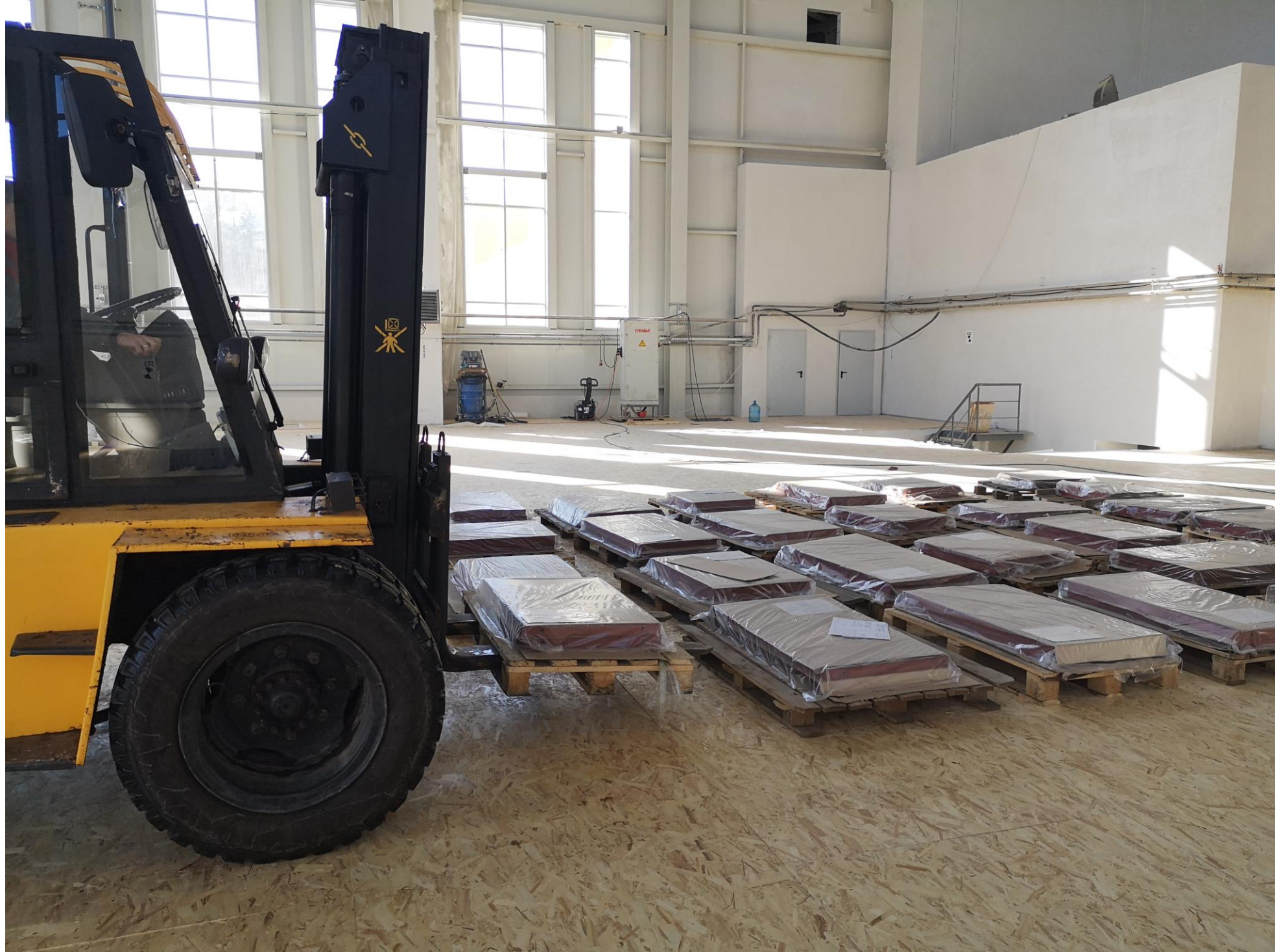
Разгрузка подрельсовых плит . 66 шт. на 33 поддонах.
