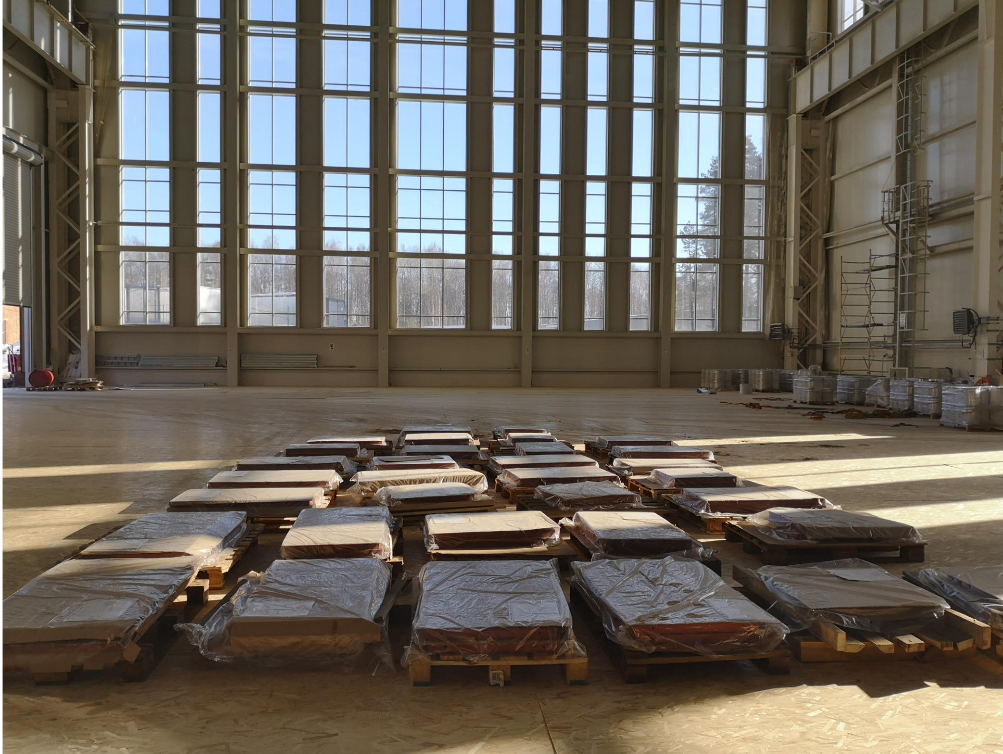
Размещение подрельсовых плит в зале разгрузки.
