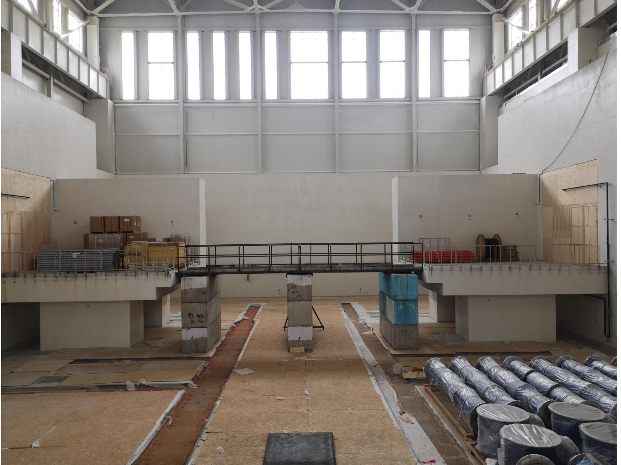
На бетонные блоки установлен металлический телепорт, соединяющий два балкона.
