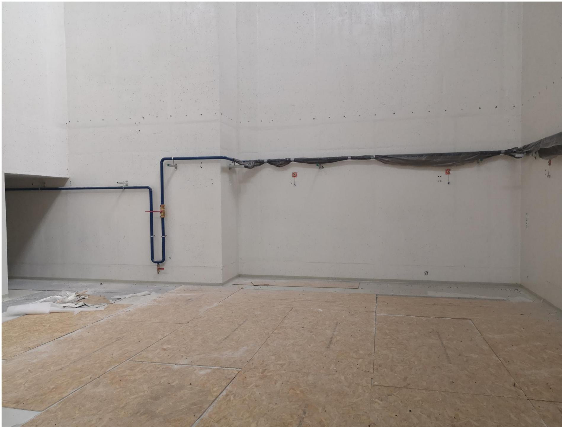
Демонтирована временная водяная система отопления. Убрана грязь после покраски антипожаркой.
