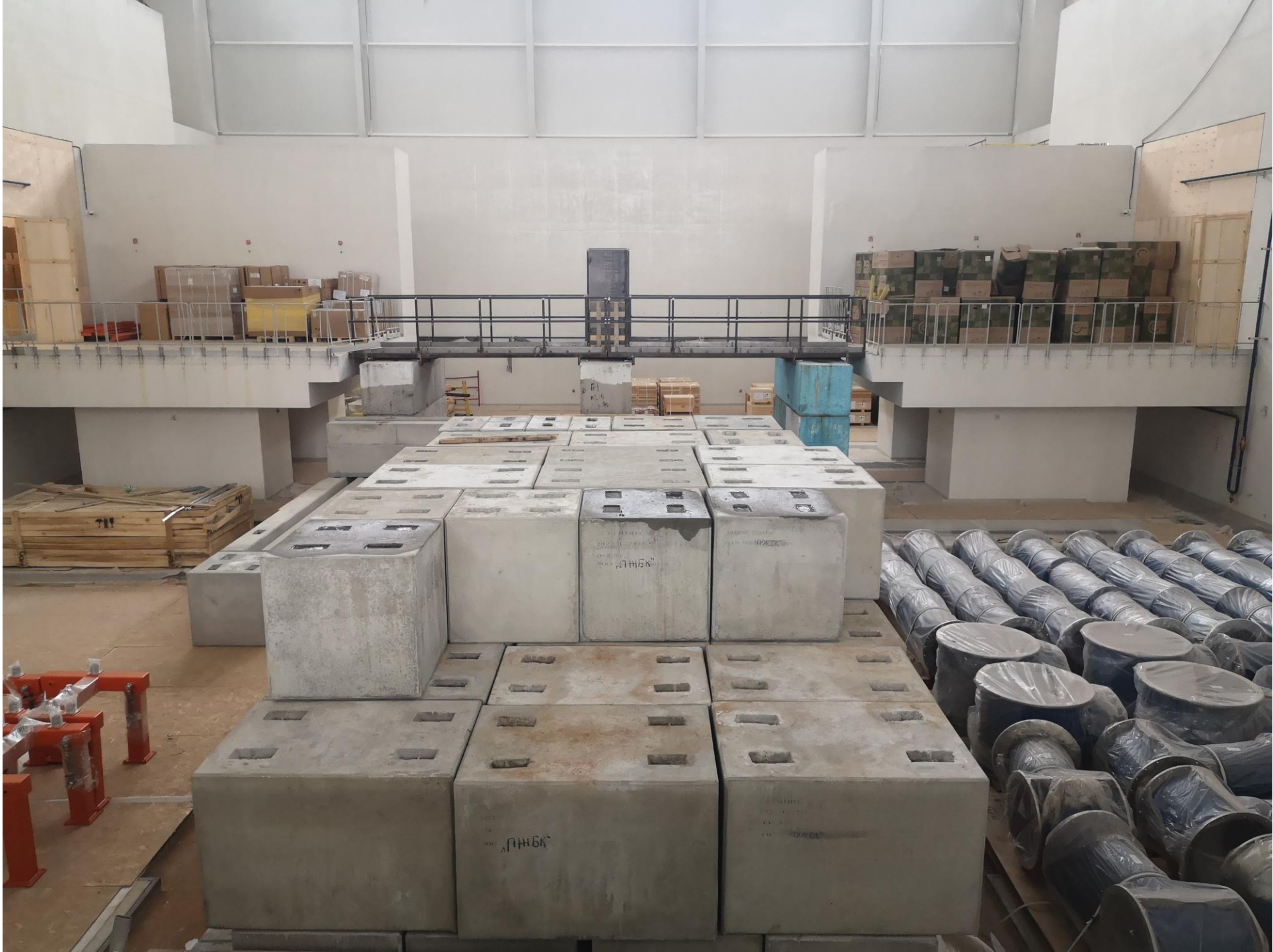
Бетонные блоки биологической защиты (временное складирование).
