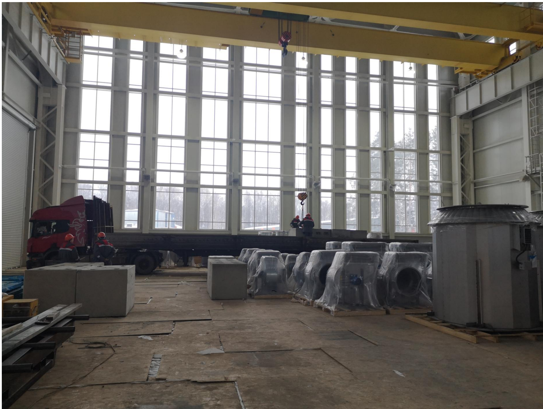
Процесс разгрузки бетонных блоков биологической защиты.
