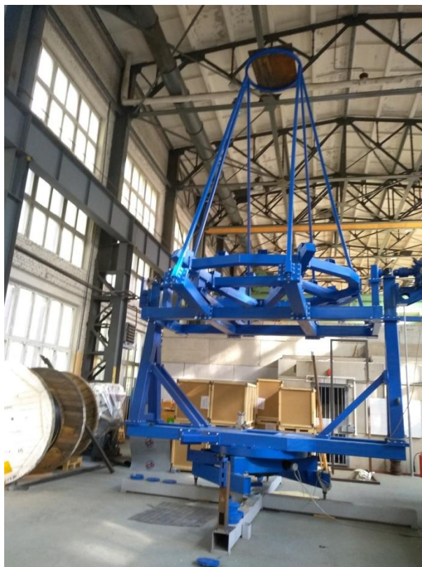
Рис.4. Монтаж АЧТ-3 в сборе в мастерской ОИЯИ
