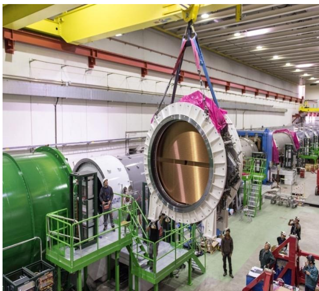
Рисунок 10. Процесс установки одной из четырех строу-камер в эксперименте NA62
