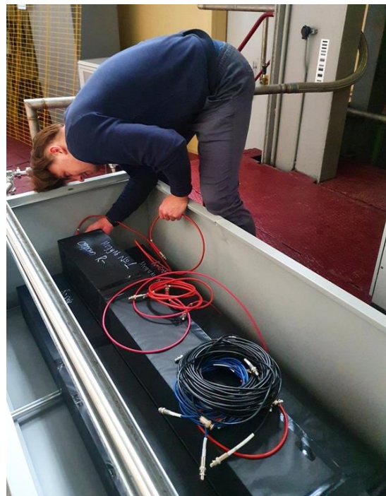
Рис,9 Установка нейтронных модулей.
