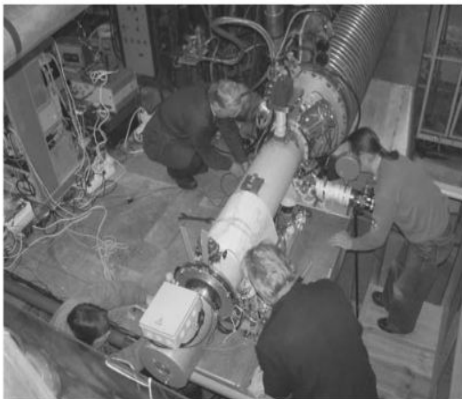
Рис. 1.4. Установка источника «Крион-2» на высоковольтном терминале ЛУ-20
