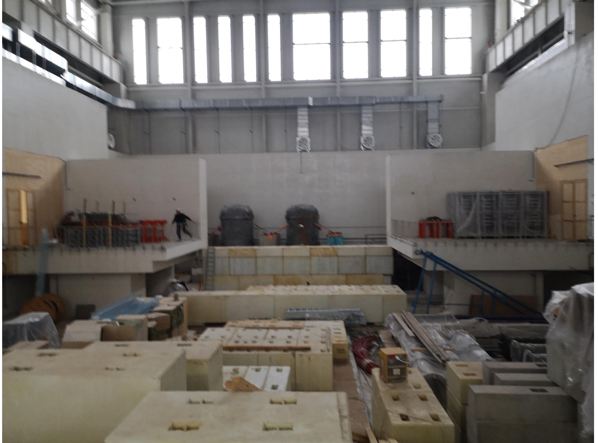
Монтаж временного межбалконного перехода из блоков биологической защиты.
