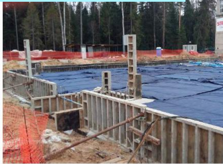
Фото 6: Бетонные работы, ростверки МРД
