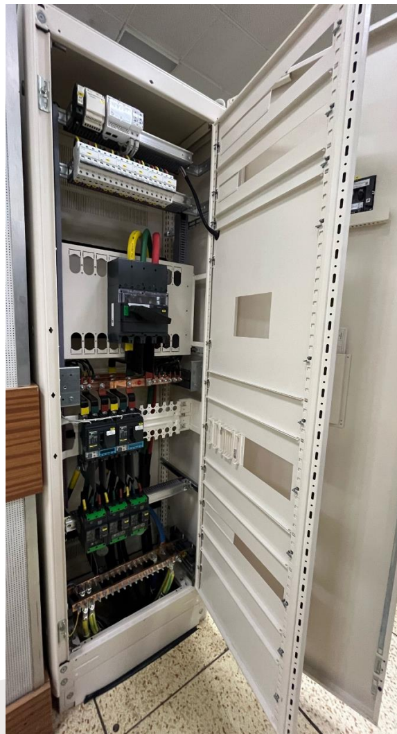
Установка распределительных шкафов “Чистого питания” для подключения к системе питания TIER2 модуль №2.
