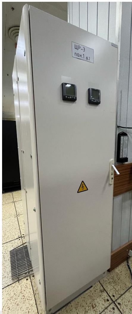
Установка распределительных шкафов “Чистого питания” для подключения к системе питания TIER2 модуль №2.
