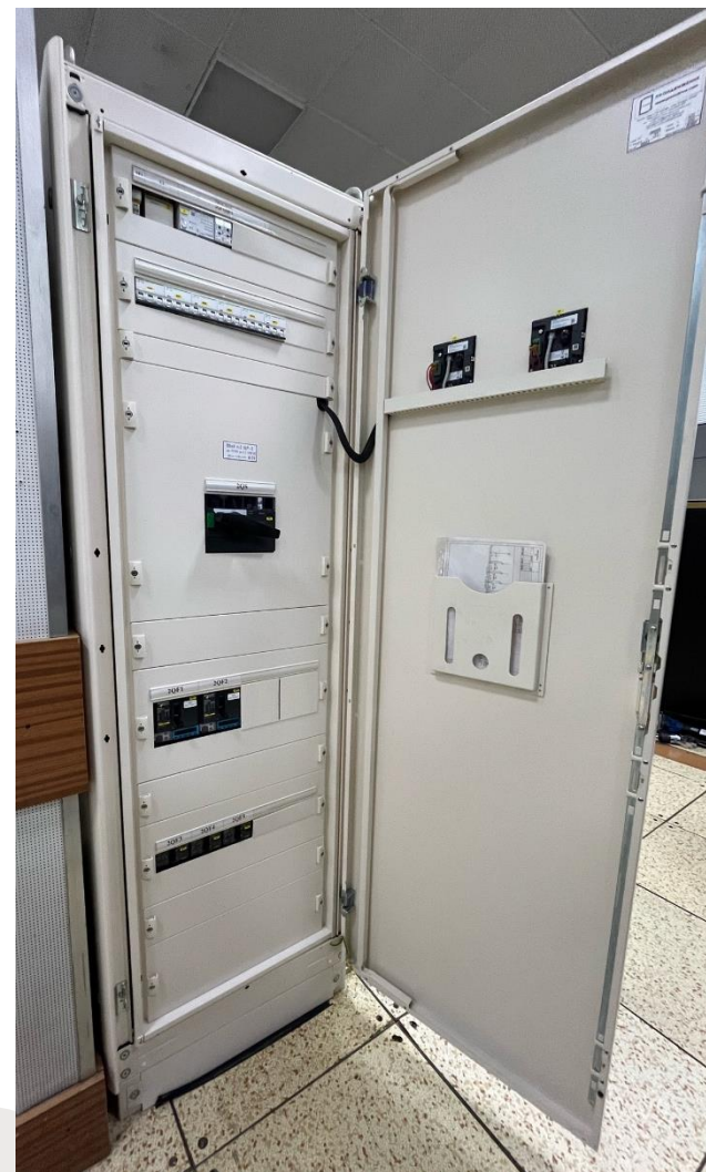
Установка распределительных шкафов “Чистого питания” для подключения к системе питания TIER2 модуль №2.
