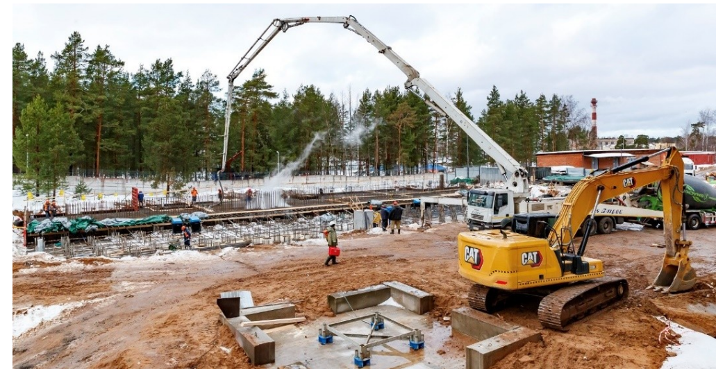
Start of grillage pouring 21.12.23
