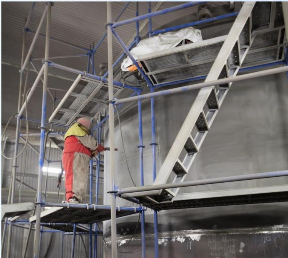
На предприятии внедрена технология газотермического напыления износостойких антикоррозийных покрытий методом металлизации с применением оборудования EuTronic Arc Spray 4.
