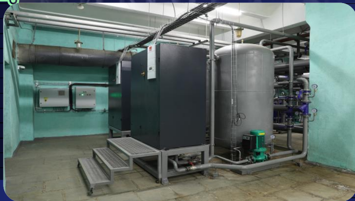
Холодильные машины зала МИВК
