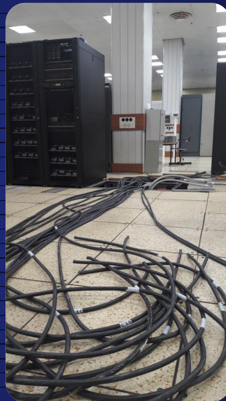
Подготовка линий электропитания суперкомпьютера
