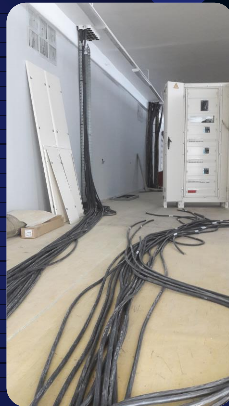
Подготовка линий электропитания суперкомпьютера
