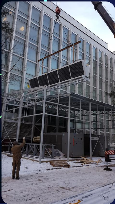
Установка сухой градирни
