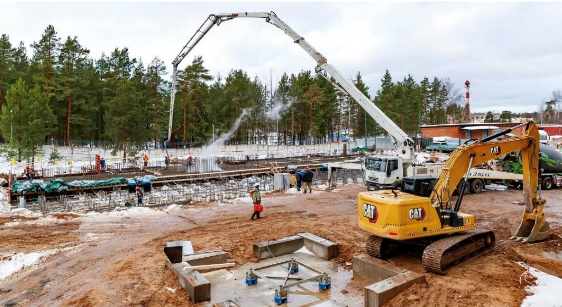
Start of grillage pouring 21.12.23
