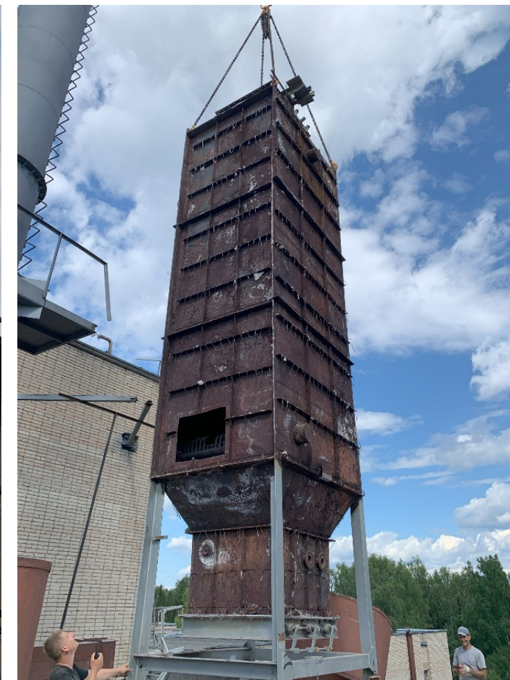
Демонтаж старого ВТО
