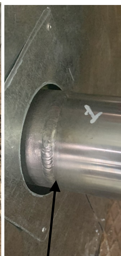
Сварка натриевых трубопроводов
