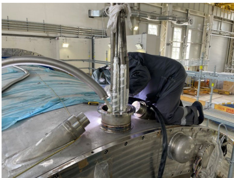
Рис 3.2.3. Подготовка узла чимни специалистами ОИЯИ
