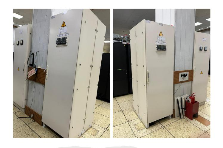
Установка распределительных шкафов "Чистого питания" для подключения к системе питания TIER2 модуль №1.
